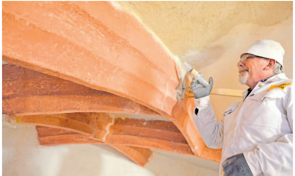
Injektion für die Stadtkirche. Mit Spritzen wird der Putz an der Decke wieder fest gemacht.
