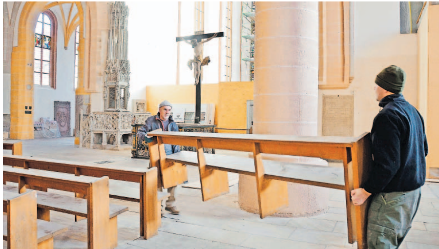
Auch die Holzböden unter den Bankreihen werden erneuert. Deshalb wurden gestern in der Stadtkirche die Sitzbänke abmontiert. An dieser Säule soll die neue Holzkanzel entstehen. Foto: Wilhelm
