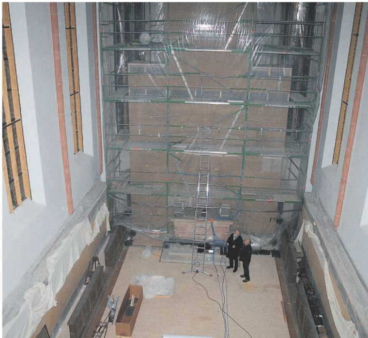
Das Folien-Zelt über dem Hochaltar füllt den Chorraum aus. Es macht deutlich, wie groß der Altar insgesamt ist. Foto: Hess
