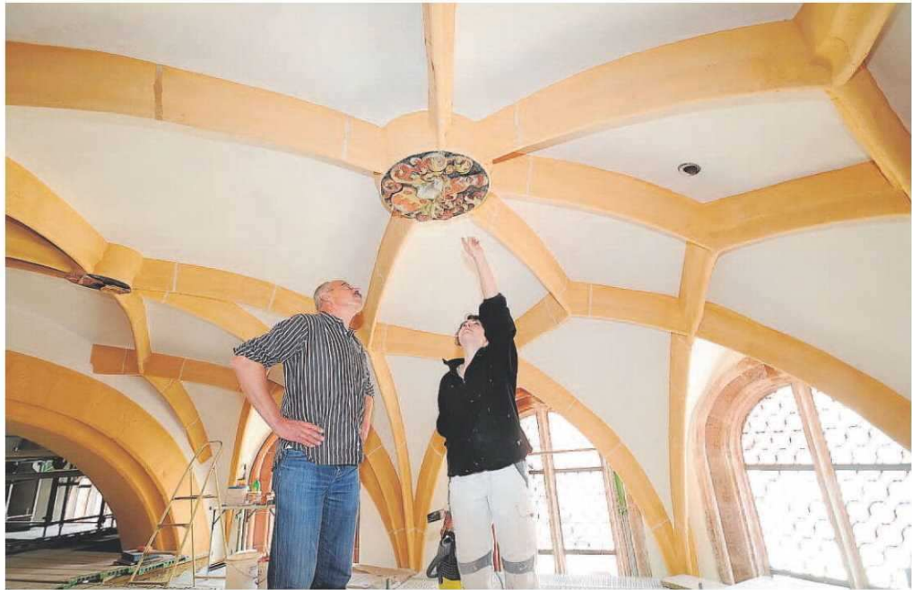
Pfarrer Paul Hermann Zellfelder und eine Restauratorin begutachten den sogenannten Schlussstein mit dem kunstvoll verzierten Wappen der Familie Rosenberger im Deckengewölbe der nach dieser Familie benannten Rosenberger-Kapelle
