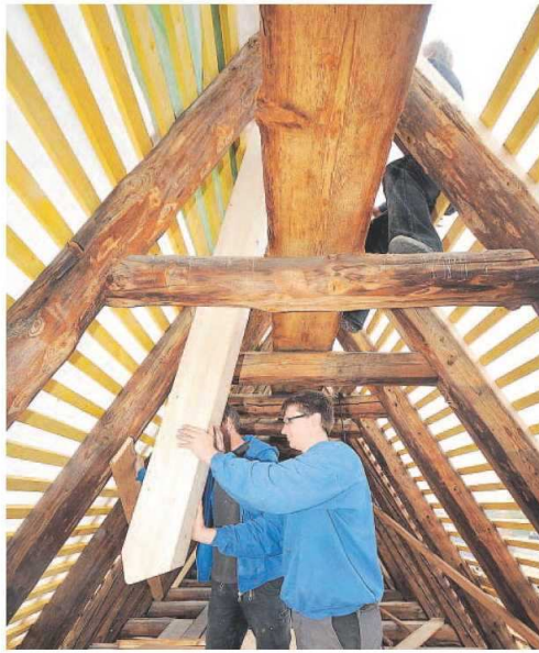
Im Dachstuhl setzen die Zimmerleute Seitenstreben für die drei letzten Sprengwerke ein. Fotos: Schmitt
