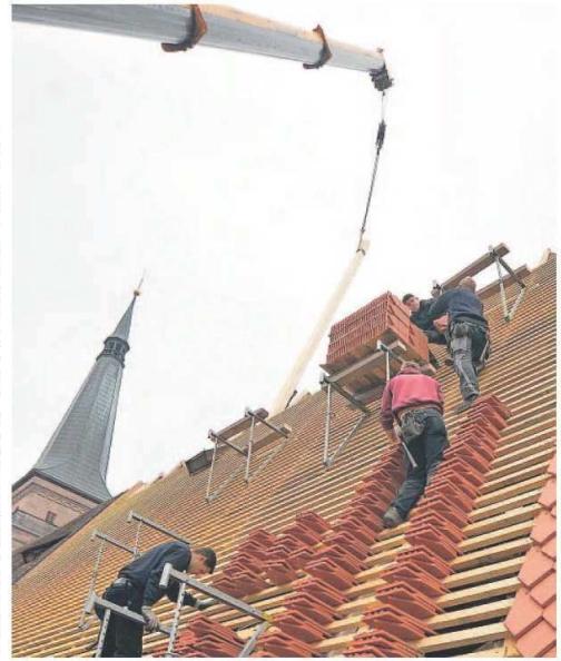
Jetzt muss noch der Deckel drauf. Die Dachdecker sind seit einigen Tagen schon eifrig bei der Arbeit.
