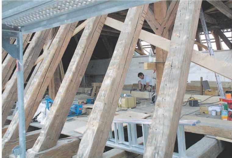
Baustelle Stadtkirche: Um an die Balken zu kommen, musste das Dach abgedeckt werden. Die Zimmerleute müssen die Statikprobleme von Schwabachs Wahrzeichen lösen. Foto: Hess
