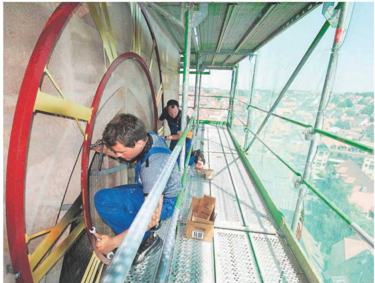
Arbeiten über den Dächern der Stadt. Thomas Hollering (vorne) und Jörg Freese befestigen eines der vier Zifferblätter am Kirchturm. Der Rahmen ist jetzt rot, die Ziffern sind vergoldet.
