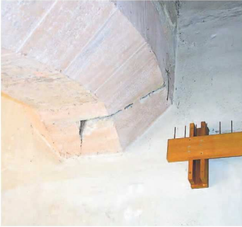
Orgelbauer Gerald Haap und die freiwilligen Helfer schlichten die hölzernen Orgelpfeifen auf der Orgelempore aufeinander (Bild rechts). Die mächtigen hölzernen Orgelpfeifen sind abgenommen. Nun zeigt sich deutlich der tiefe Riss im Arkadenbogen nahe der Giebelwand (Bild links).
