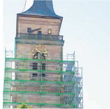
Ein Gerüst umgibt den Turm der Stadtkirche. Bis Ende der Woche soll es komplett sein. Foto: Hess
