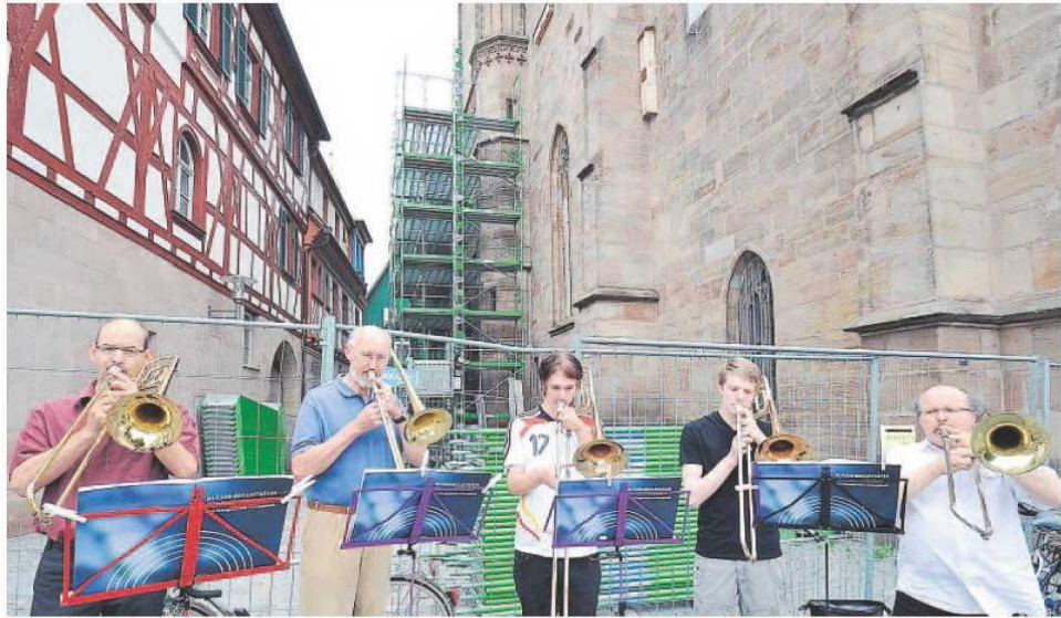
Aufmunternde Klänge durch den Posaunenchor des evangelischen Dekanats unter der Leitung von Klaus Peschik (rechts). Das Gerüst am Turm steht, die Arbeiten können beginnen. Foto: Schmitt
