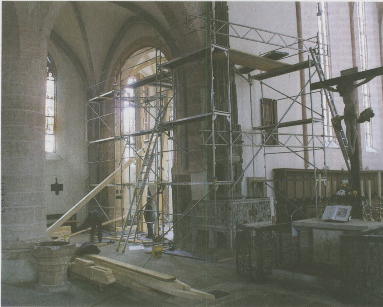
Die Notsicherung der Stadtkirche. Um den Altarraum steht ein Gerüst. Den Gewölbebogen zur Rosenbergekappelle stützen Rosenbergebalken. Unser Bild entstand, als sie in Position gebracht wurden. Foto: Hess
