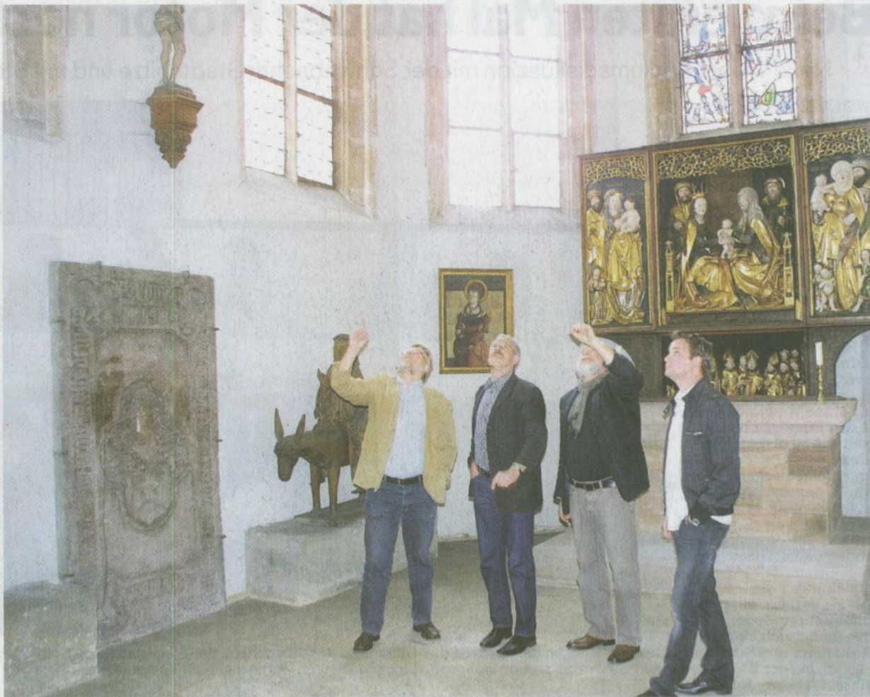
Sie begutachteten in der Stadtkirche die Schäden in der Rosenberger-Kapelle und dem vordersten Joch des nördlichen Seitenschiffs (von links): Bürgermeister Dr. Roland Oeser, Geschäftsführender Pfarrer Dr. Paul-Hermann Zellfelder, Architekt Jürgen Lemke und Bau-Ingenieur Tobias Lemke.
